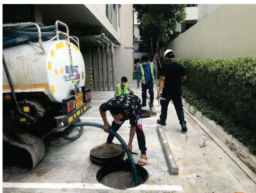
สูบลตะกอน และไขมันระบบบำบัดน้ำเสีย
