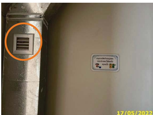
ระบบระบายอากาศห้องพัสดุฝอยประจำชั้น
