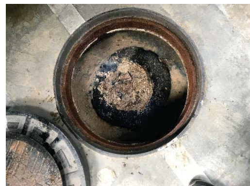
สูบลตะกอน และไขมันระบบบำบัดน้ำเสีย
